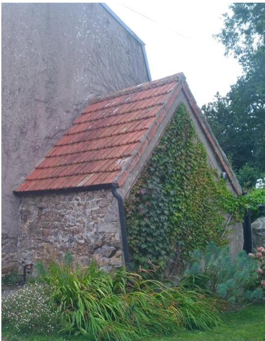
*Tuiles sur rempannage pignon, une tuile clouée verticalement protège le bois de la ferme en charpente.*
