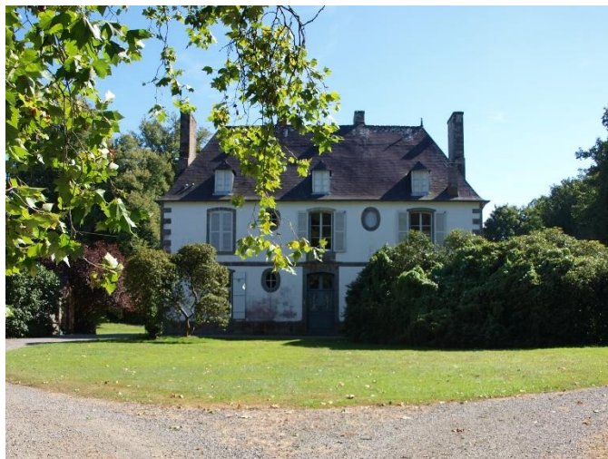
Le château de La Chênaie, façade principale
