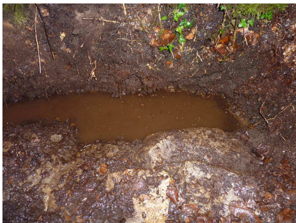
Photo 9: Troisième sondage après retrait de l'empierrement, aménagement écoulement d'eau de surface, coté sud de la voie
