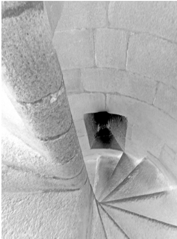
5 – L'escalier à vis pour l'accès aux étages
