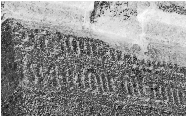
2 – Inscription portant la date de début de construction.
