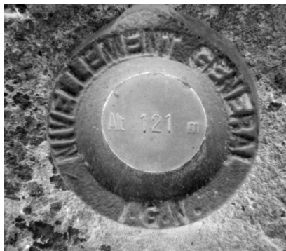
4 – Repère de nivellement
