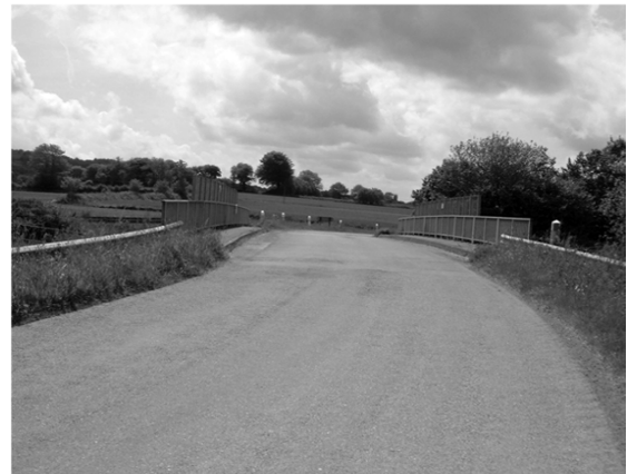
27 - Passage au dessus de la voie ferrée Paris-Brest.
