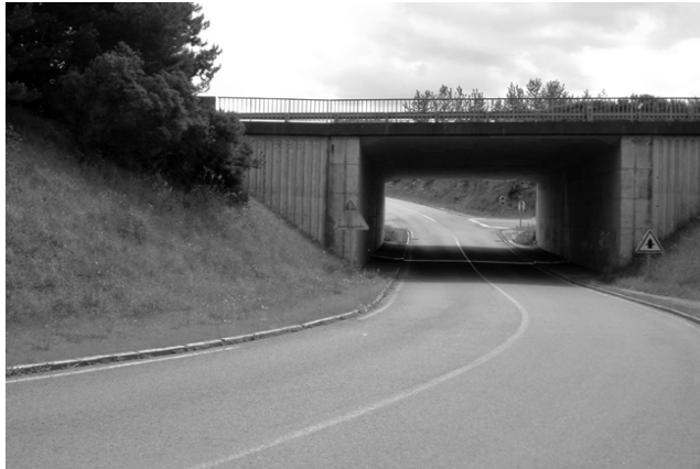
26 :- Passage sous la route Lannion Guingamp.
