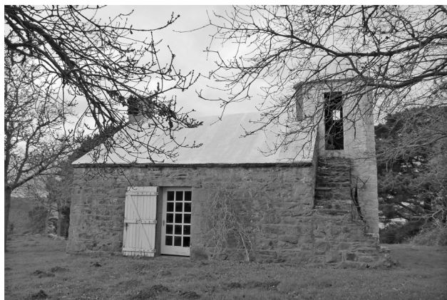
1 – Ile à Bois, le 27-12-2008 : corps de garde avec tourelle et escalier
