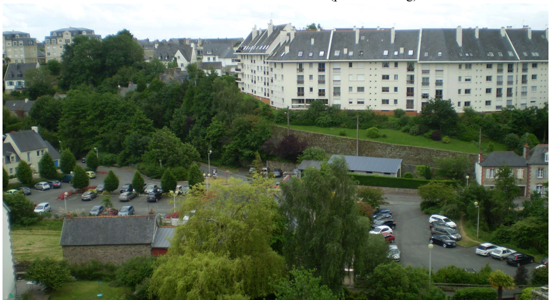
31 - Vue générale du parking du Stanco (en 2012)
