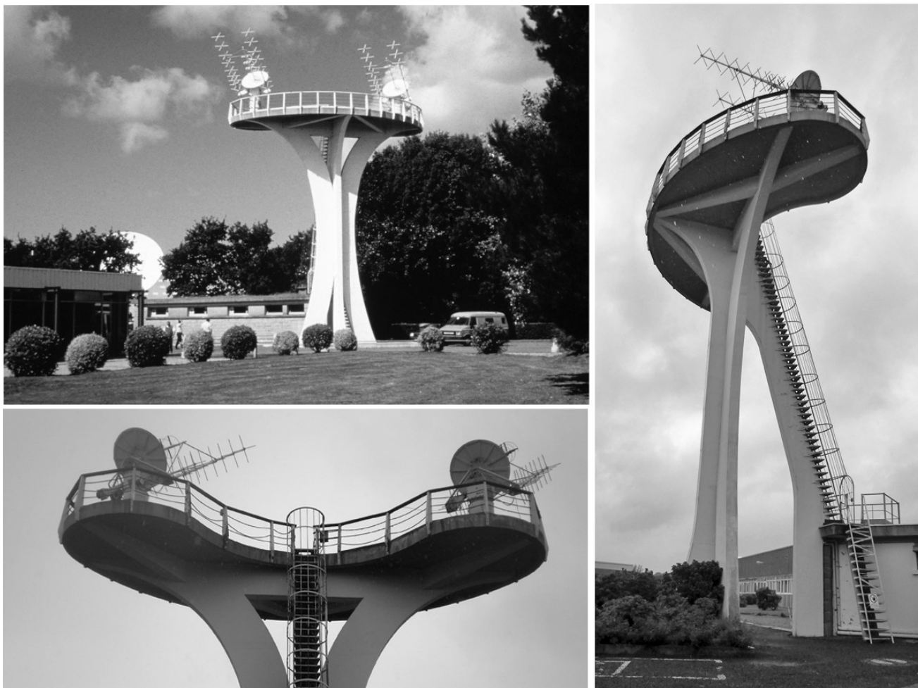
45- (Haut à gauche) Vue générale 46 – (à droite) Tour 47 – (Bas à gauche) Plate-forme « Haricot »
