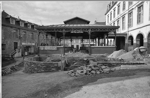
55 - Au cours des travaux (1999)
