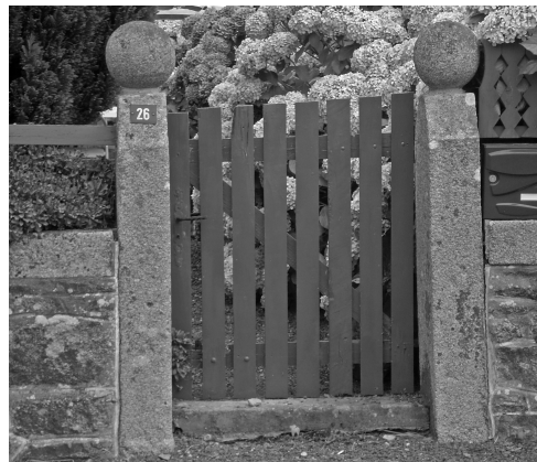
Pierres taillées sommet plat à deux pentes, sommées de deux boules rajoutées
