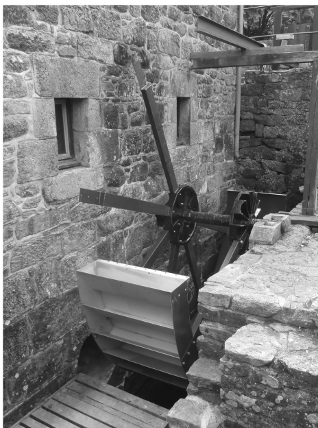
7 - Roue en inox en cours de montage
