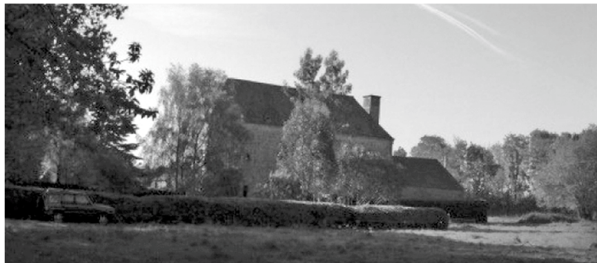
Fig 6 : Arrière du manoir de Kerousy
