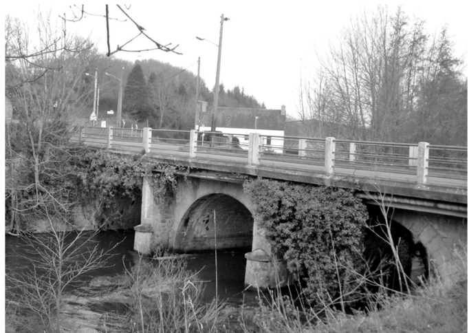
Fig 19 : Pont Ste-Marguerite, ancien Pont Ezer
