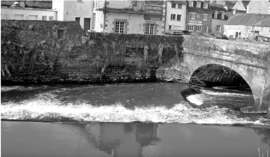
Fig 9 : Gué de la Roche-Derrien, sous le pont.
