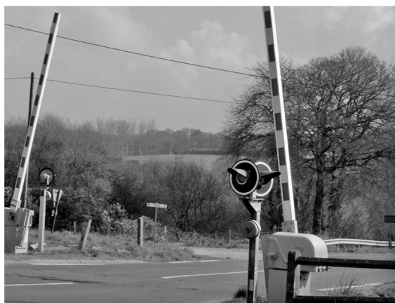
Fig 17 : Le passage à niveau de Plouisy
