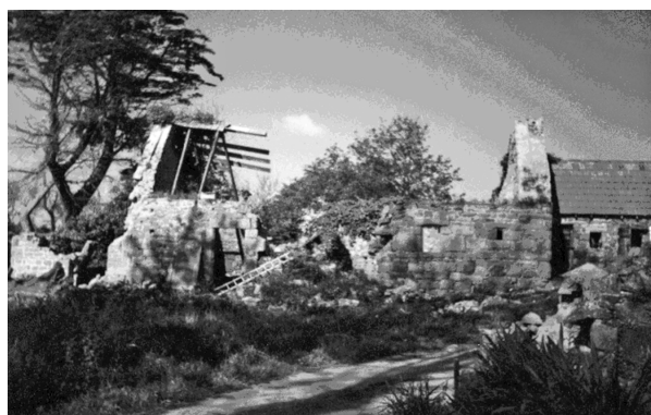
Bâtiment principal de Roch-louarn après une tempête au XXème siècle
