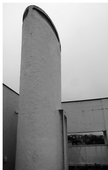
3 : La cheminée cachant la ventilation
