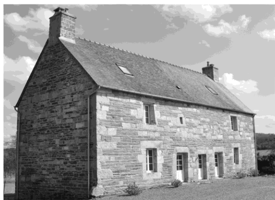
23 - La métairie de l'ancien manoir du Dresnay restaurée
