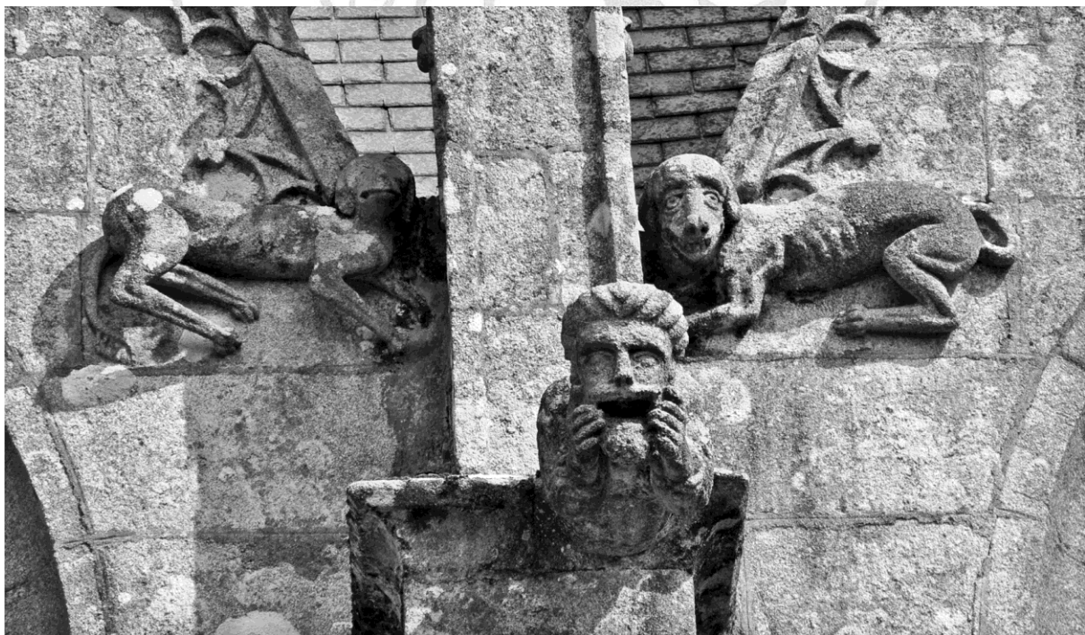
Détail des gargouilles de l'église St-Ivy
