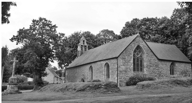
Figure 17 : Chapelle du Danouet et sa sacristie
