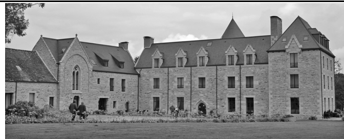
2 – Manoir de Kergrec'h restauré, façade avant
