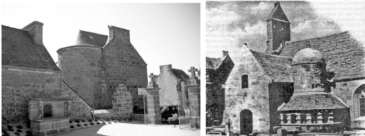
Fig 2: La tour sud complète à gauche sur la grand'maison et le vieux clocher à droite.
