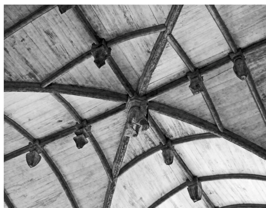
Figure 39 : Voûte de la chapelle
