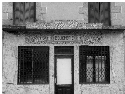
Figure 16 : Façade ancienne boucherie
