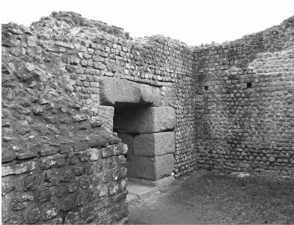
Figure 19 : Poterne sud du bâtiment initial
