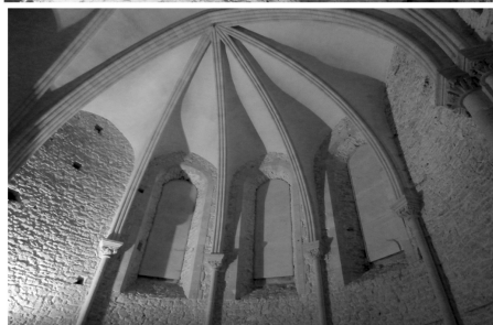
Figure 12 : Partie de la voûte de l'église au dessus des Thermes
