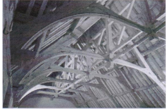
Charpente du château
