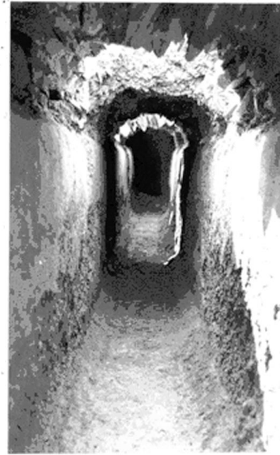
La canalisation de l'aqueduc de Carhaix
