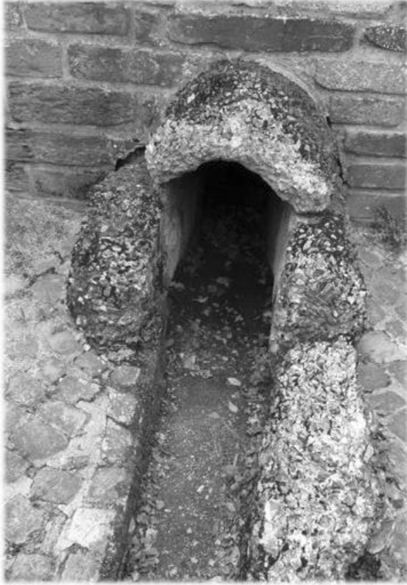
Elément de l'aqueduc
