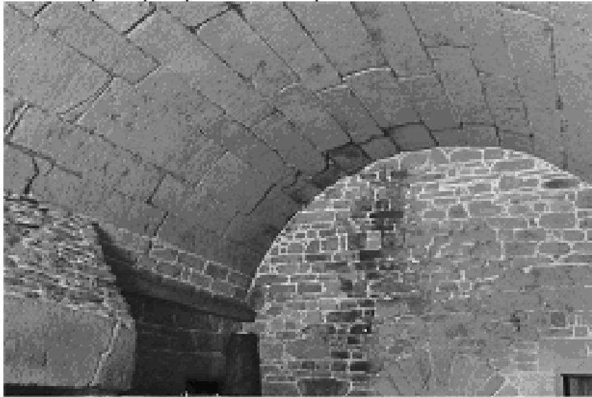
10 : Voûte en pierre de la boulangerie
