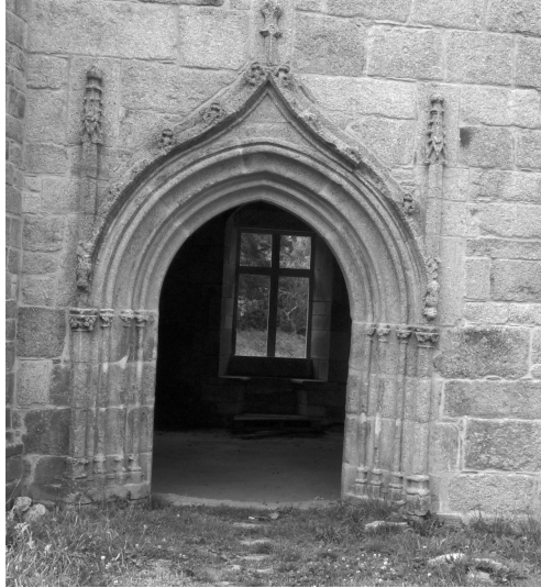
17 : Porche d'entrée du manoir
