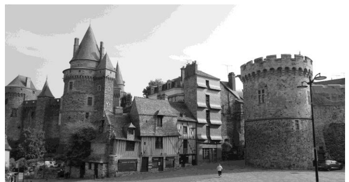
Figure 8 : Vue générale et porte d'Embas
