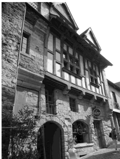
Figure 2 : Maison à pans de bois à Vitré
