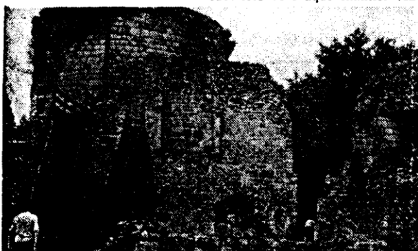
LANNION. — Voilà deux ans et demi que l'ARSSAT a démarré l'impressionnant chantier de Tonquédec.
