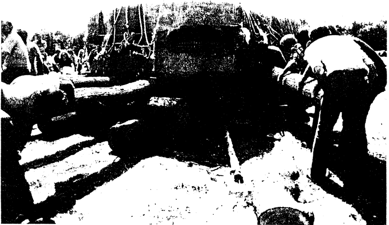
10 - Bougon (Deux Sèvres): expérience de transport d'un bloc de 32 tonnes en 1979. Cl. J. P. Mohen.
