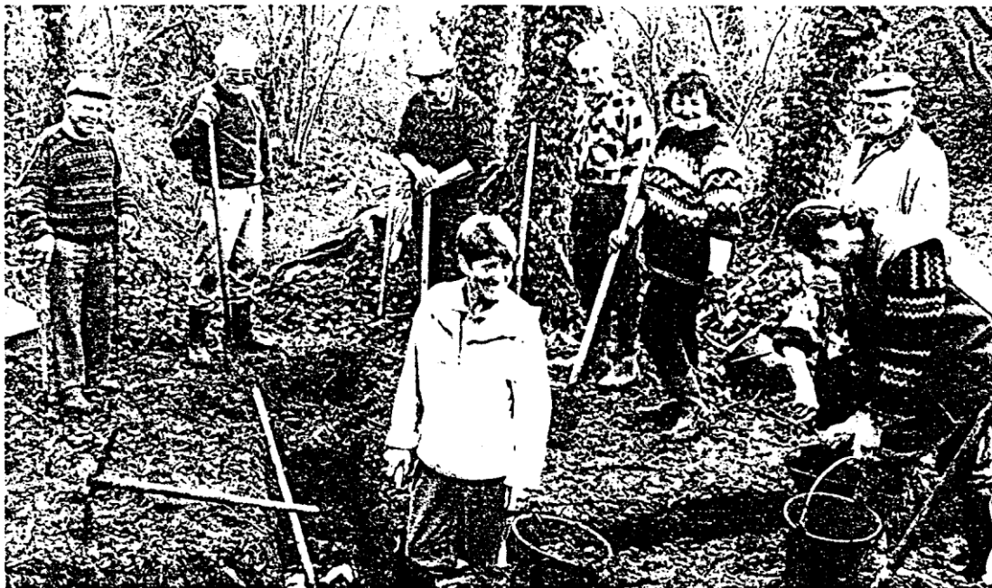
Le courageux noyau de fidèles des chantiers de l'ARSSAT à la tâche : on creuse, on creuse !
