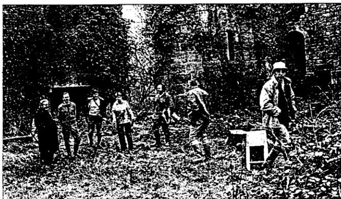
Les bénévoles de l'association des nouveaux amis de Coetfrec ont organisé une journée de débroussaillage des abords du château de Coetfrec, dans le but de baliser un périmètre de sécurité. L'accès au château est en effet interdit au public, compte tenu des dangers que présente l'état des ruines.
