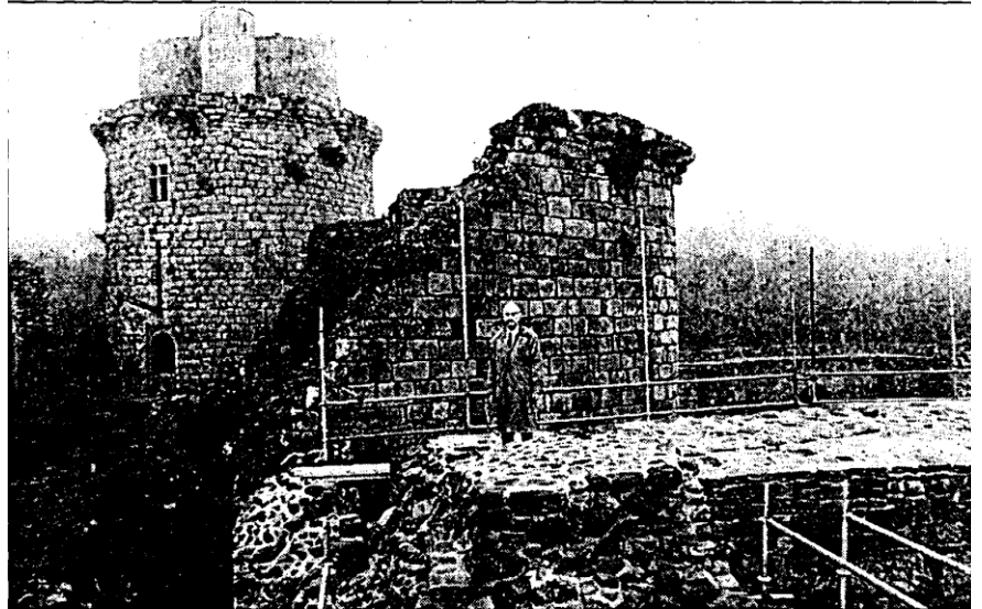
Du sommet de la tour Nord-ouest consolidée, le comte de Rougé annonce la prochaine campagne de restauration des deux tours du châtelet situées derrière lui.
