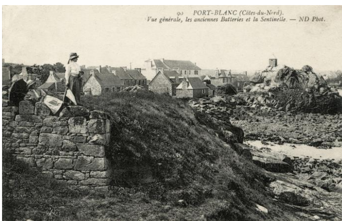
Figure 12 : Vue générale de l'ancienne batterie et la Sentinelle.
