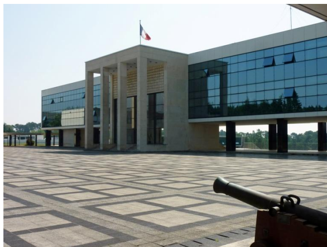
Figure 2 : L'état-major des Écoles
