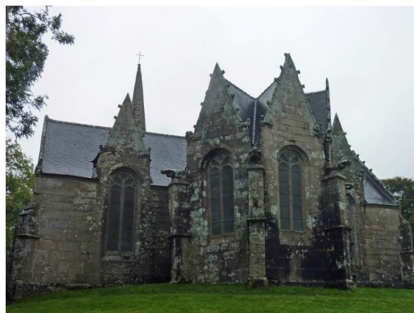
Figure 6 : chevet à noues
