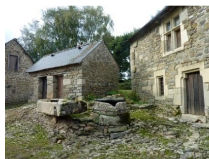
Figure 27 : Manoir entrée principale
