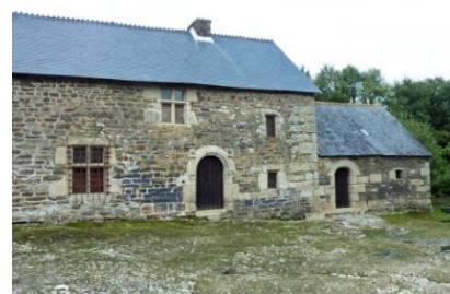
Figure 26 : Manoir vue de la façade
