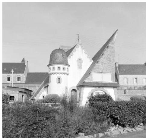
Figure 11 : Villa Strniste (1936-1938) Ile Grande, Roger Le Fanchec architecte, Inventaire général, Guy Artur, 2001
