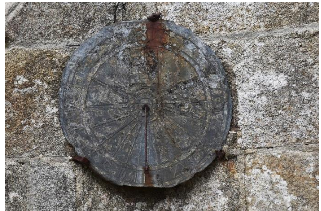
Figure 5 : Cadran circulaire, gravé sur ardoise, daté 1635.
