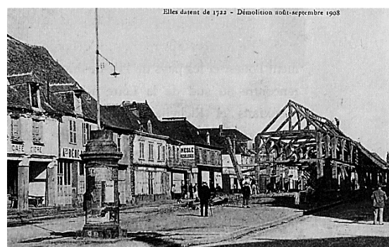
Saint-Méen-le-Grand, Ille-et-Vilaine : La halle en cours de démolition.
