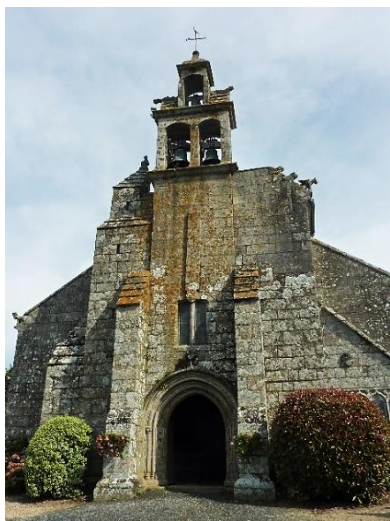
Figure 1 : Église de Trégrom.
