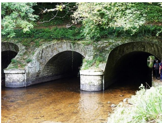
Figure 11 : Les arches du viaduc.
