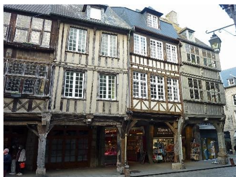
Figure 13 : Les maisons porches.
