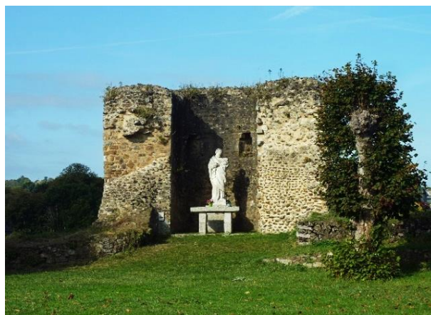
Figure 7 : Tour nord-ouest – oratoire du XIX e siècle.
