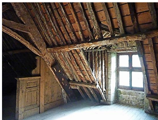
Figure 3 : Les charpente des greniers.
