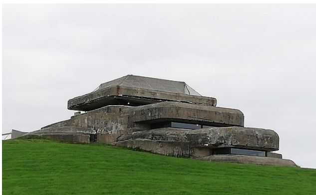
Figure 5 : Le poste de commandement de tir.
