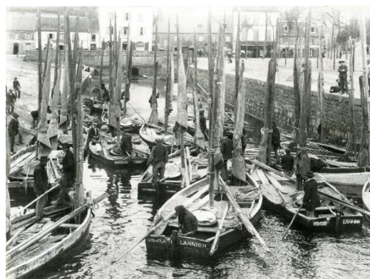
Figure 6 : Déchargement du sable.
