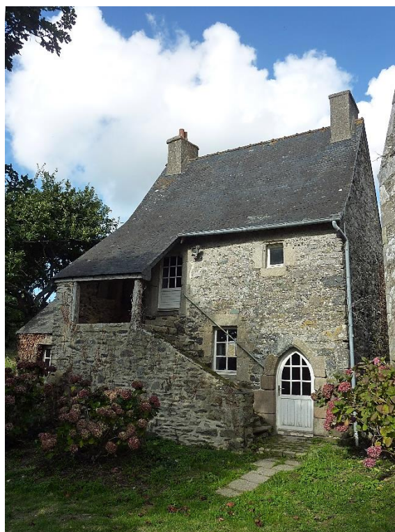
Figure 2 : Maison du chapelain
