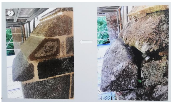
Figure 6 : Reprise de la maçonnerie
