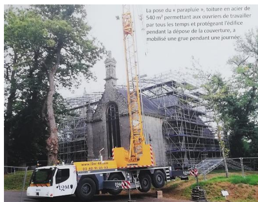
Figure 5 : La pose du parapluie-toiture 2
