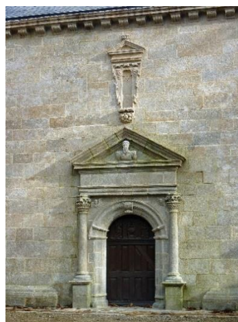
Figure 2 : Porte Renaissance de la chapelle sud
