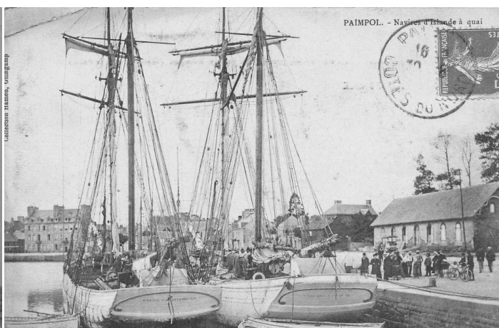
Figure 4 : Navires d'Islande à quai
