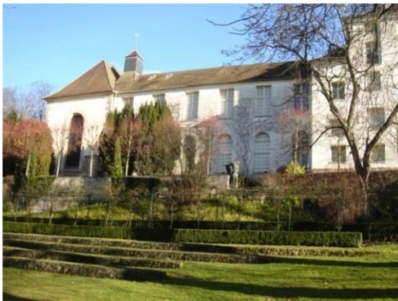
Figure 14 : 2 bis rue Maurice Denis, 78100 Saint-Germain-en-Laye.
