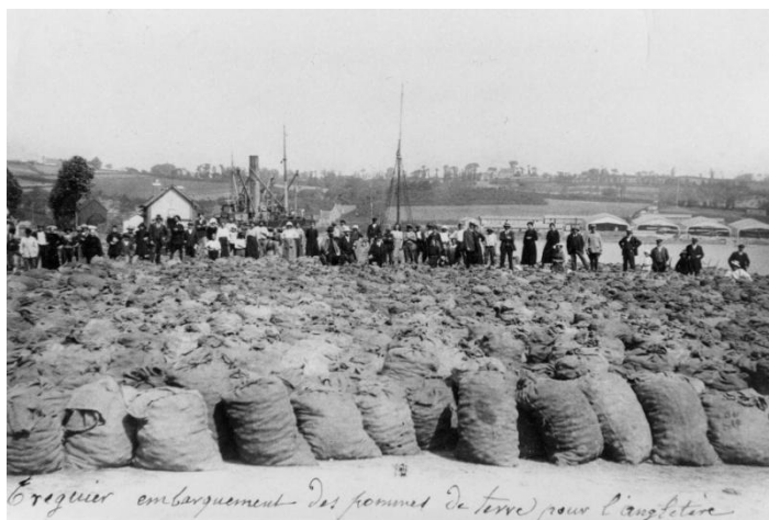
Figure 9 : Sacs de pommes de terre sur les quais de Tréguier.
