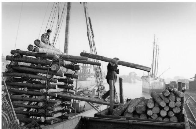
Figure 4 : La cage formée avec les poteaux de mine.
