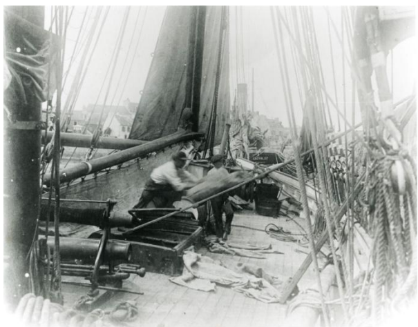
Figure 8 : Chargement des pommes de terre à la glissière à Roscoff.
