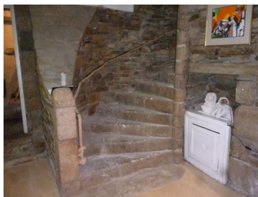
Figure 4 : Escalier d'une maison lannionaise
