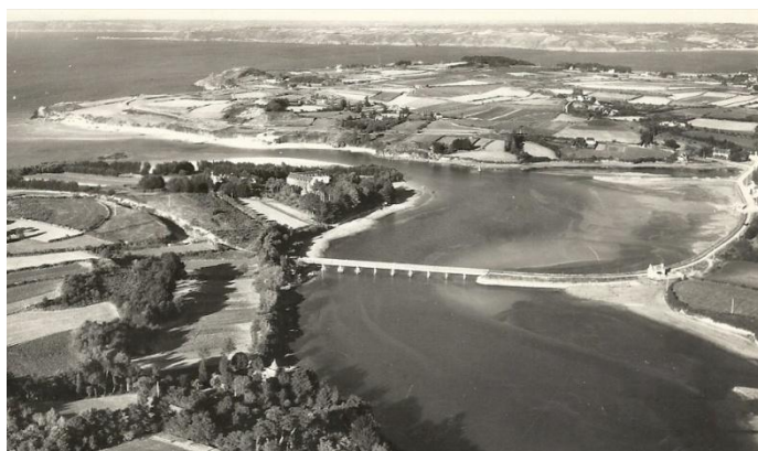
Figure 12 : Le pont Cornic vu d'avion et l'estuaire du Douron.
