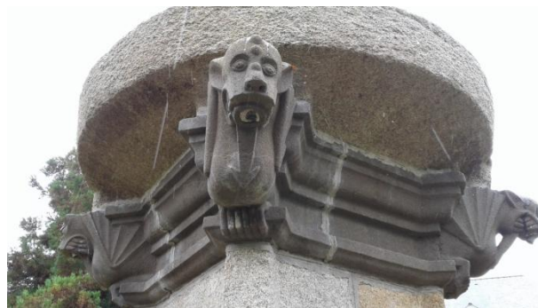
Figure 2 : Détail des corniches - fontaine de Kergomar
