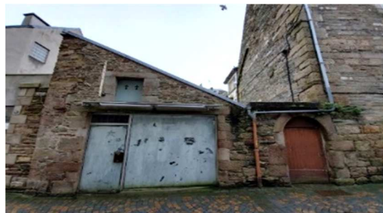
Figure 3 : Arrière du bâtiment
