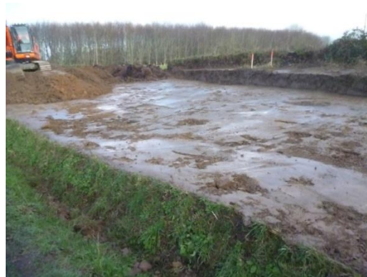
Figure 2 : Vendredi 17 janvier, 12h00. En cours de décaissement
