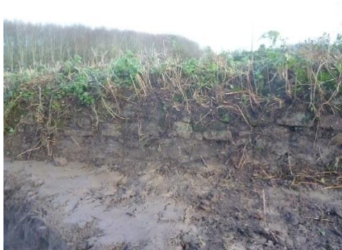
Figure 1 : Photo du mur de séparation parcellaire.
