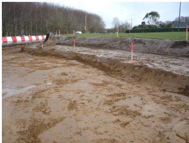
Figure 11 : 2 e décaissement (-30 cm ca). Sol stérile.
