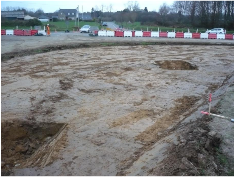
Figure 8 : 1 er décaissement (-50cm ca). On aperçoit une bande arciforme de limon noirâtre entre les deux sondages.
