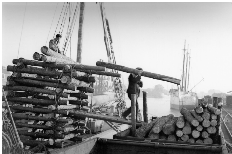
Figure 2 : A Cardiff, en 1936, le dundee Domino décharge des troncs de sapin de Bretagne destinés à étayer les mines de charbon. Cette construction provisoire appelée « chapelle » permet de mettre les poteaux à hauteur pour le dockeur qui les charge dans un wagon
