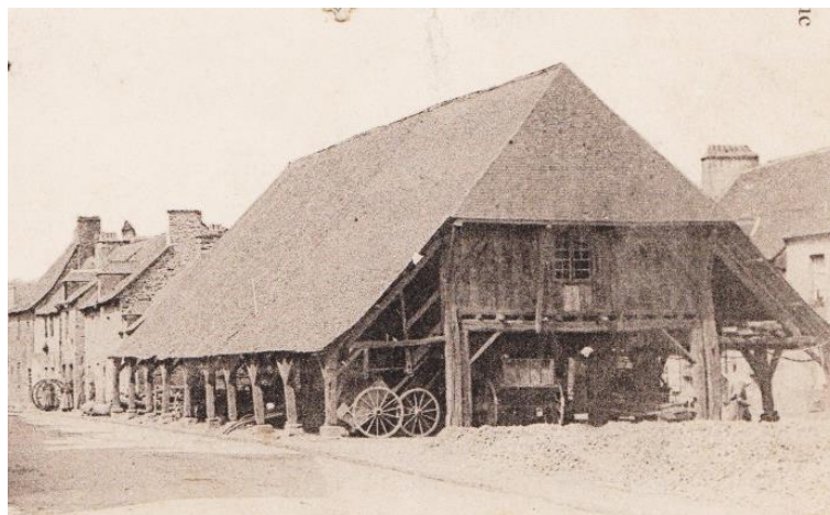
Figure 4 : Halles de la Chèze, construite sur un plan identique à celles de Lannion
