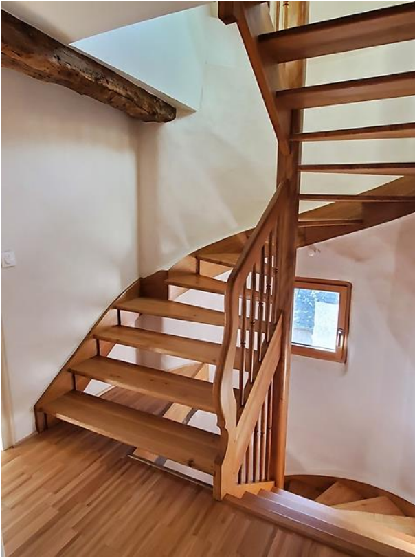
Figure 7 : Nouvel escalier en chêne massif
