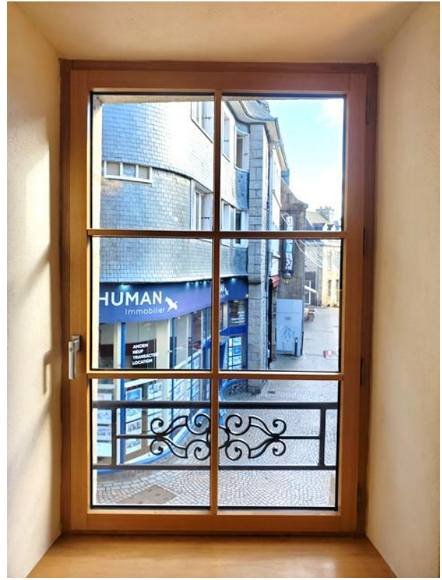
Figure 8 : Menuiserie en chêne, garde-corps en fer forgé et murs à la chaux
